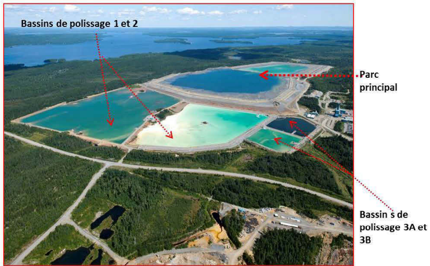
Figure 5-5 : Parc à résidus LaRonde et ouvrages connexes
