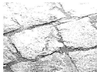
Figure 2.10 : Pavé en pierre naturelle.
