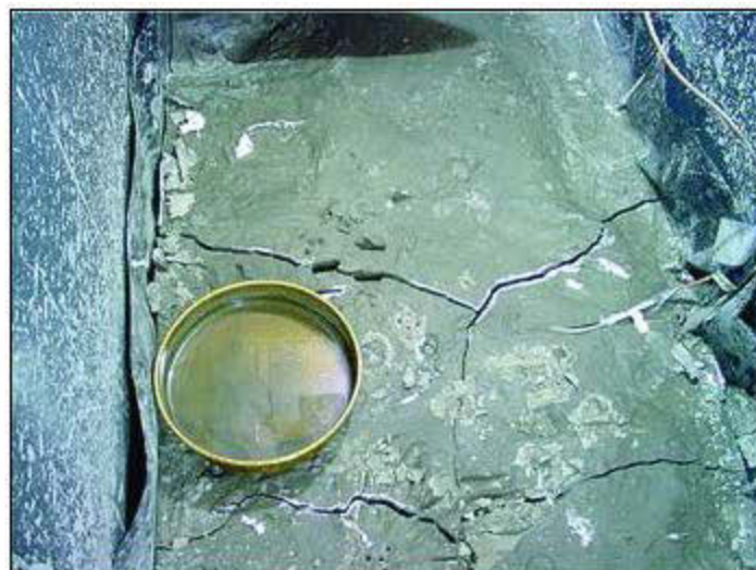
Figure 2-11: Essai à grande échelle de séchage, a montré la formation de projection d'un précipité blanc, surtout dans les coins des fissures (Simms et al., 2007).
