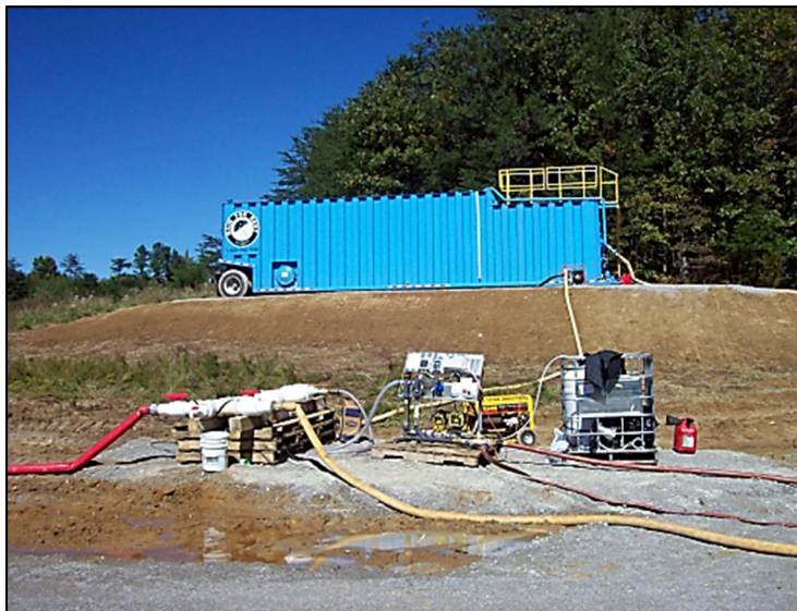
Figure 1-7 Système de préparation, de pompage de polymère, et pompage du mélange (polymère + boues) vers des tubes géotextiles
