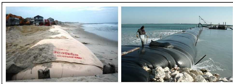
Figure 1-3. Digues de protection de bordures côtières (gauche) – brise lame (droite)
