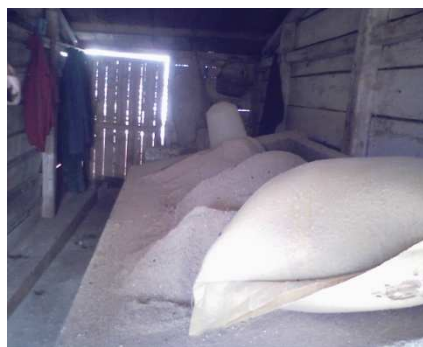
Figure 23 : Les provendes stockées dans un bâtiment présentant des accès aux rats
