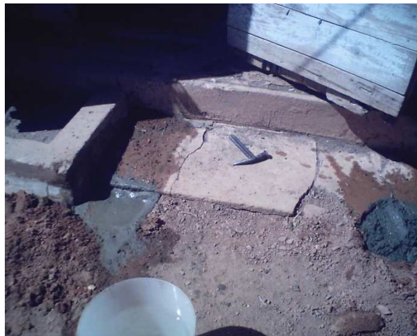
Figure 15 : Exemple de lutte à la HC : obstruction des orifices sur les bâtiments
