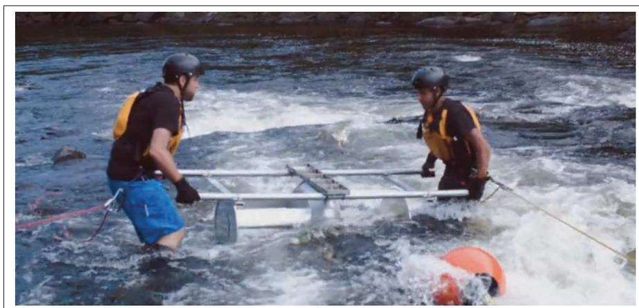
Figure 0.1 Installation de l'hydrolienne développée par Idénergie Inc.
