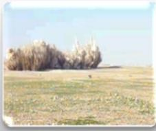
**Sautage** : C'est l'opération qui consiste à fragmenter les terrains durs par l'explosif « nitrate fuel ». Cette opération a pour but de remplir les trous forés par l'explosif en tenant compte d'un schéma de tir approprié.
