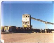
**Chargement des trains :** Cette opération consiste à charger des wagons dans une station de chargement à double voie alimentée par une roue pelle via une trémie de réception et une cascade de convoyeurs. Le positionnement des wagons est commandé par deux locotracteurs.
