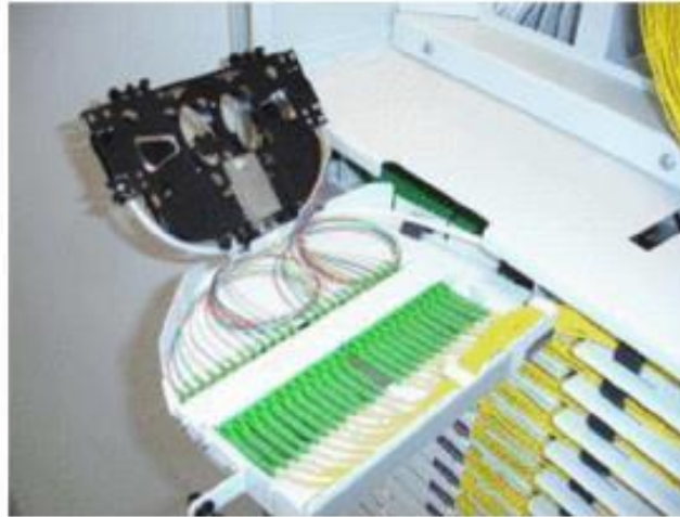
Figure 16 : Module optique d'accès
