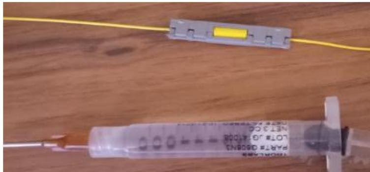
**Figure III.35** : Etape « 4 » de l'épissure mécanique
