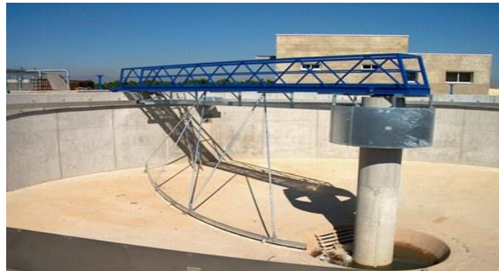
Figure 5 : Décanteur
