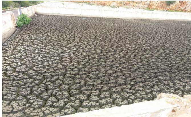
Figure 32 : Vue d'un lit de séchage rempli de boues
