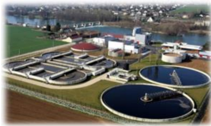
Figure 9 : Exemple d'une station par boues activées (13)
