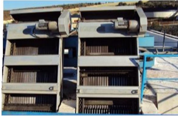
Figure 27 : Grille mécanisée
