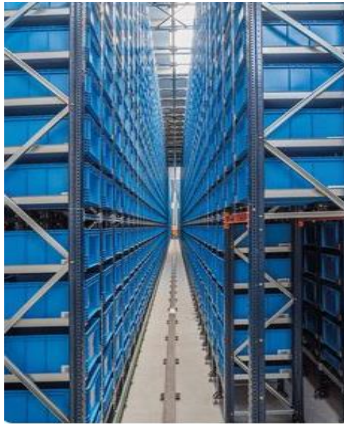
Figure 1. 4 :une allée séparant deux racks de stockage.
